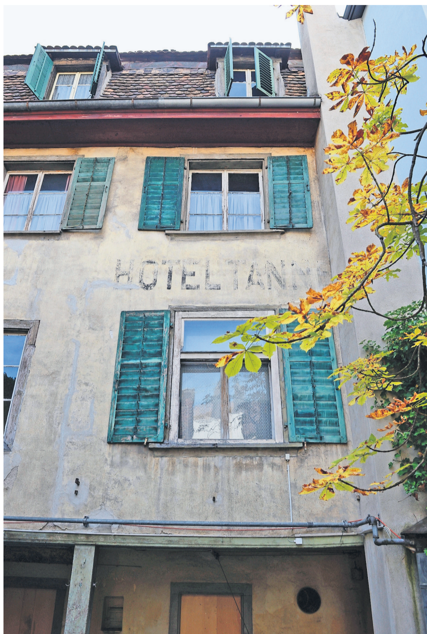
Das sanierungsbedürftige Hotel Tanne soll renoviert und verpachtet werden: Der Grosse Stadtrat stimmte gestern einer entsprechenden Vorlage zu. Bild Selwyn Hoffmann
